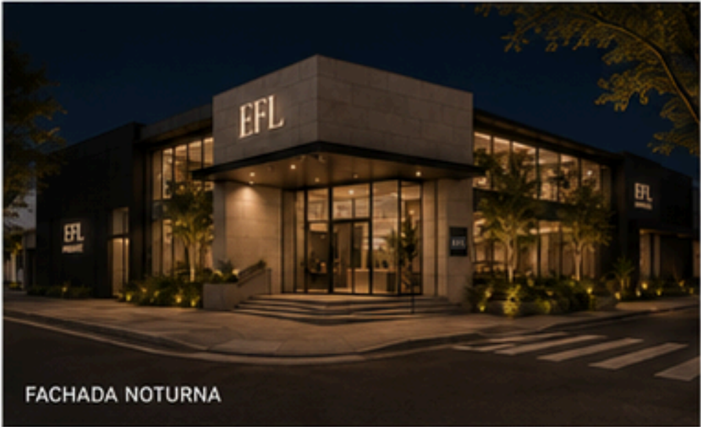
FACHADA AV. BRIG. FARIA LIMA x RUA TABAPUÃ
